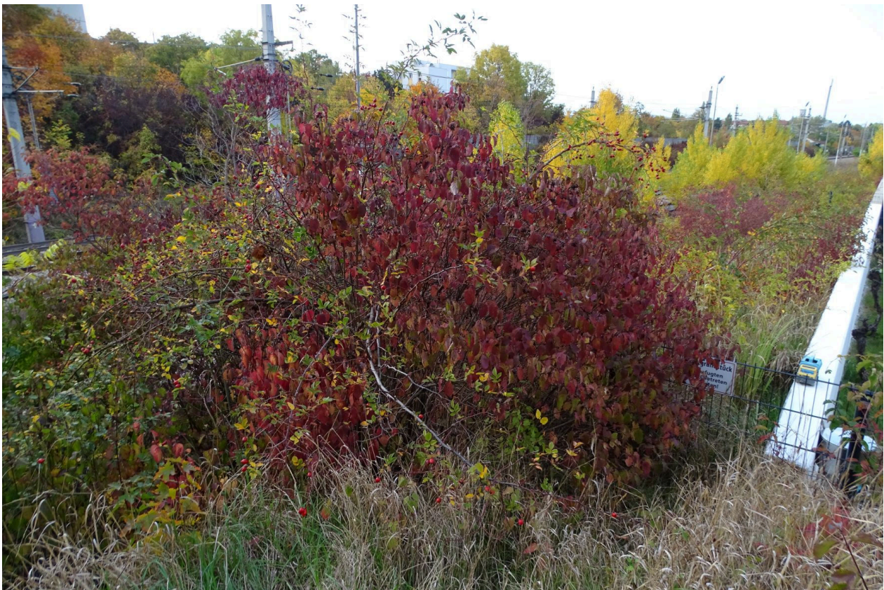
Abb. 22: Süd-Ende der Betonmauer des Vor-Bilds am Übergang zu einem noch erhaltenen wertvollen Grünzugabschnitt.
