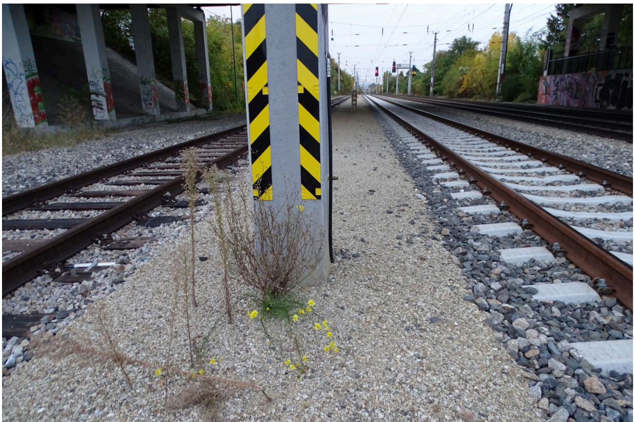
Abb. 31: Nordblick unter der Autobahn.
